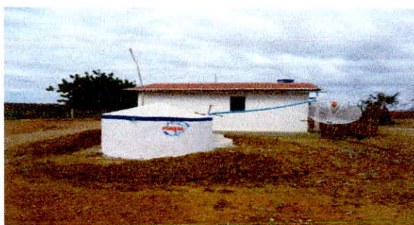
Placas de concreto com bomba manual de PVC (A)
