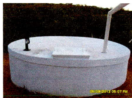
Placas de concreto com bomba manual (B)
