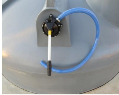
Figura 04- Bomba manual:(A) Vista geral (B) Detalhe.
