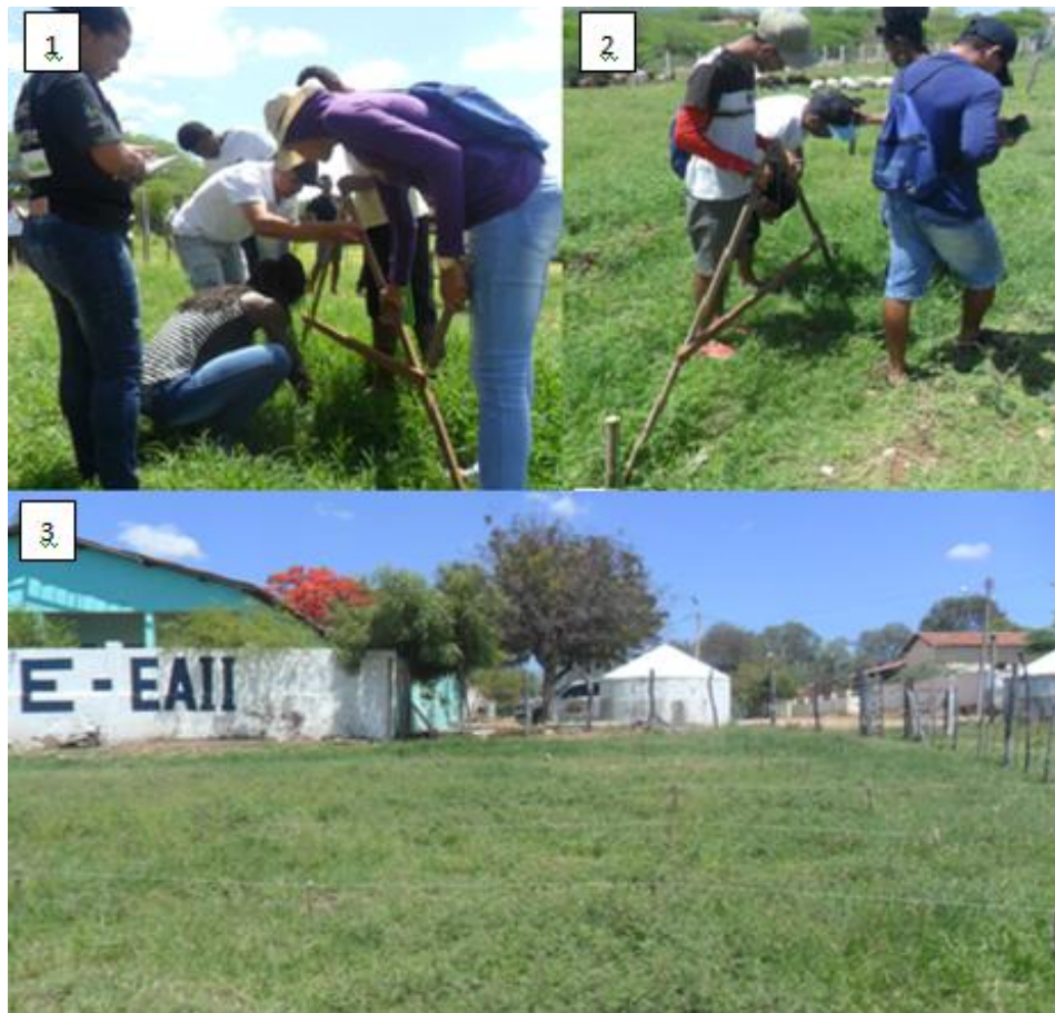
Figura 28 – Etapas para demarcação das curvas de nível com o “Esquadro em forma de A”.
