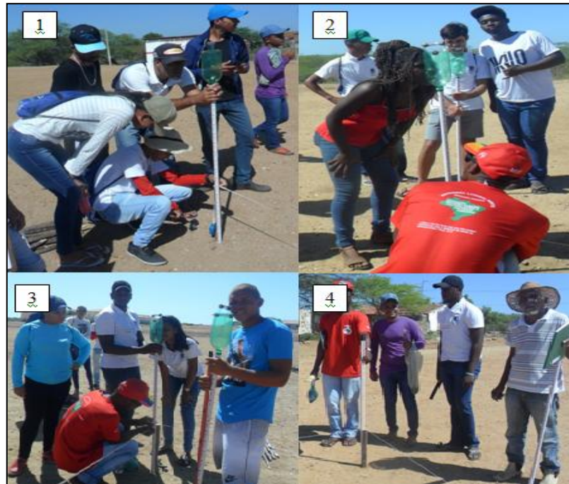
Figura 21 – Demarcação da área para construção um galinheiro com a utilização do esquadro de agrimensor.
