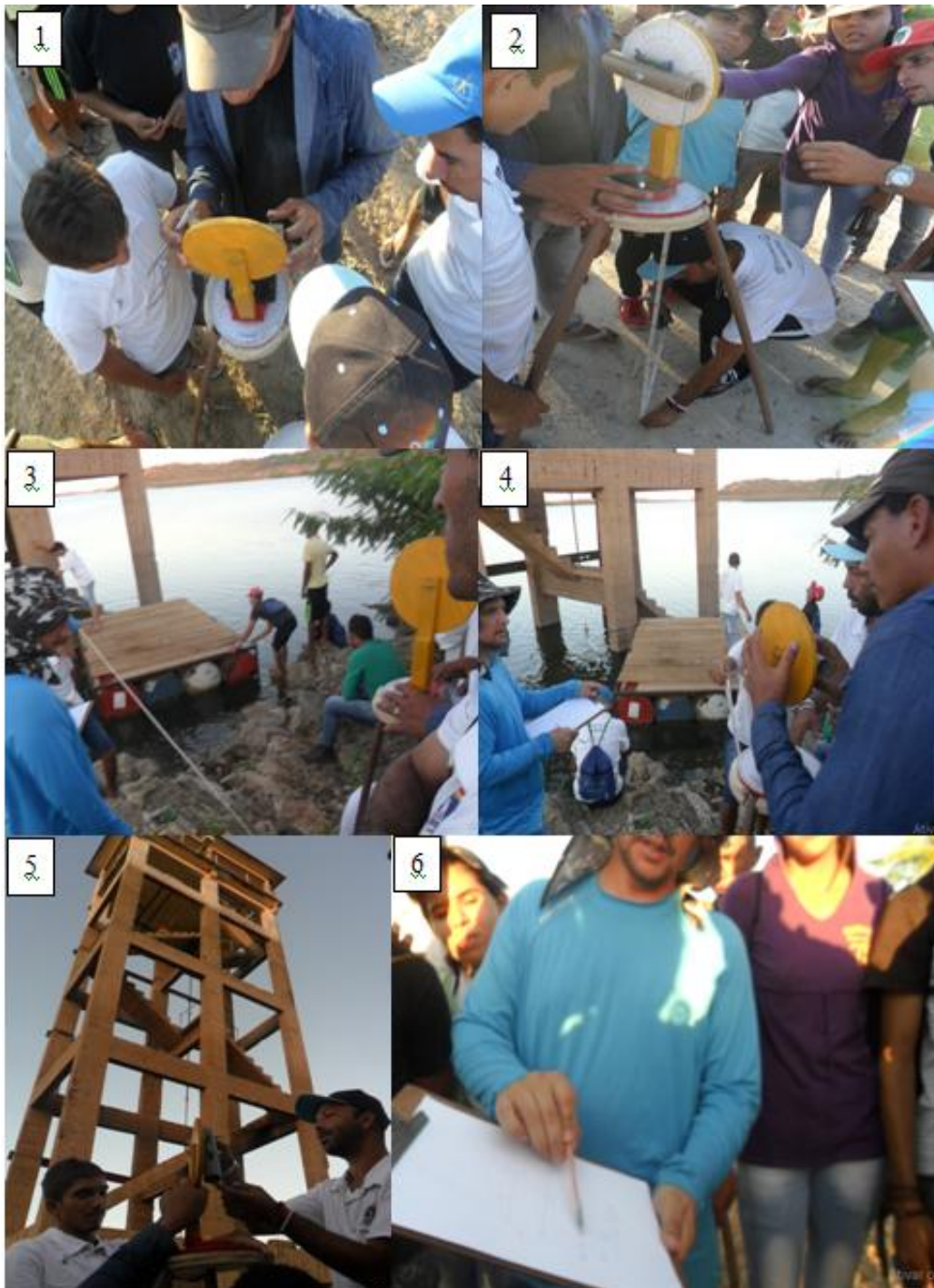
Figura 30 – Determinação da altura da torre de monitoramento do nível de água do Açude Poço da Cruz/PE com o Teodolito Alternativo.
