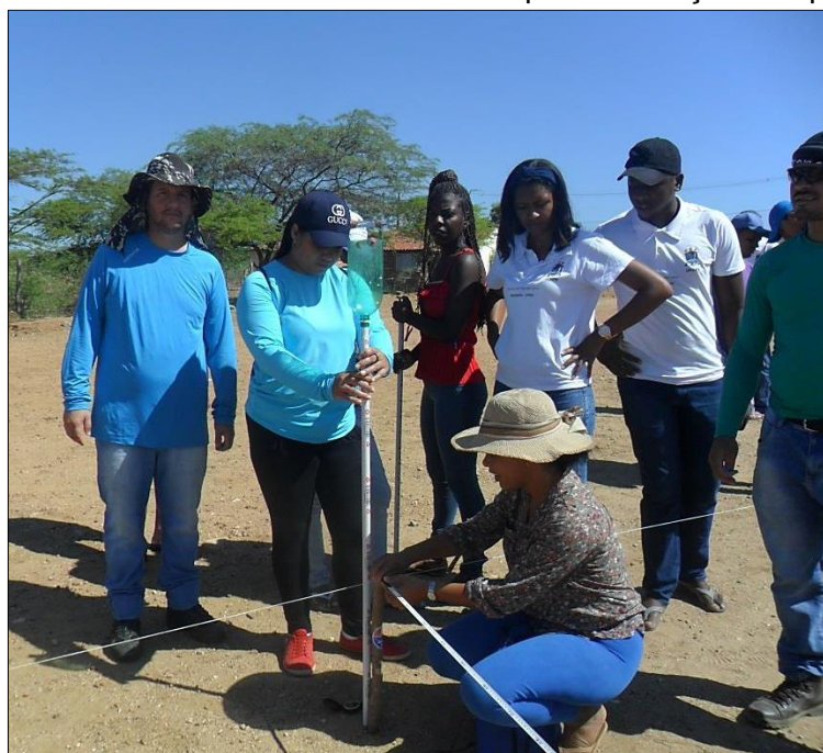
Figura 11 – Alinhamento das visadas com as balizas para marcação dos piquetes.
