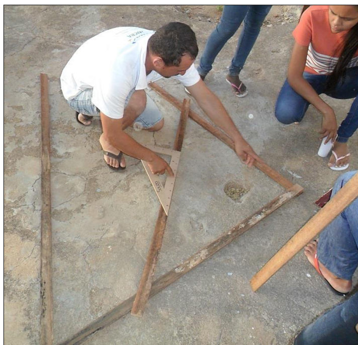
Figura 33 – Fixação das ripas formando um “A”.
