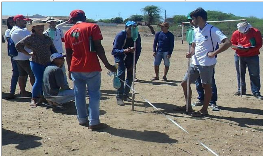
Figura 12 – Demarcação de área com uso do esquadro de agrimensor.
