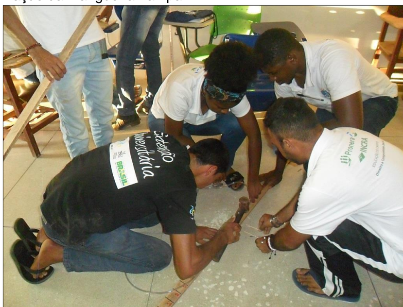
Figura 22 – Fixação da mangueira na ripa.
